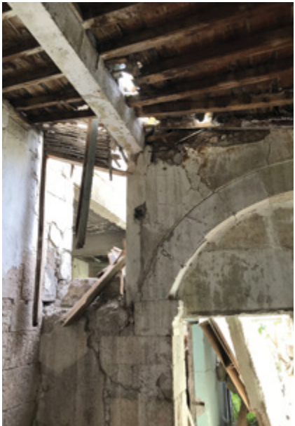
Şekil 13. CEY-27 yapısında görülen hasarlar (sol). CEY-11 birinci kat cephesinin deprem kaynaklı yıkılması (sağ).
