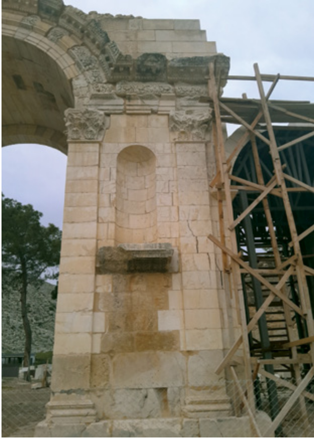
Şekil 8. Anavarza Zafer Takı'nda gözlemlenen hasarlar.
