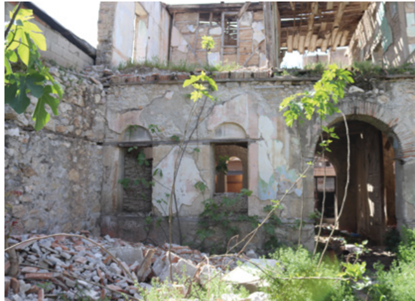
Şekil 13. CEY-27 yapısında görülen hasarlar (sol). CEY-11 birinci kat cephesinin deprem kaynaklı yıkılması (sağ).
