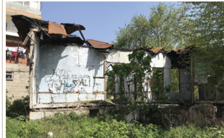
Şekil 2. Adana ili, Ceyhan ilçesi, Konakoğlu Mahallesi, 661 ada 25-29 parselde bulunan yapı, Nisan 2023.
