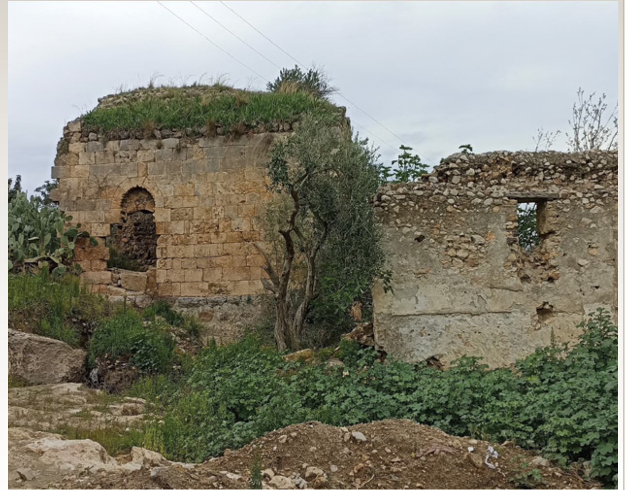
Şekil 2. Kozan, Kara Kilise güney cephesi.
