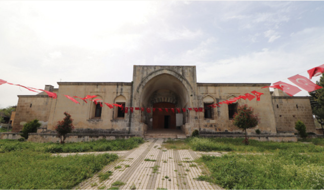
Şekil 1. Kurtkulağı Kervansarayı doğu cephesi, Nisan 2023.
