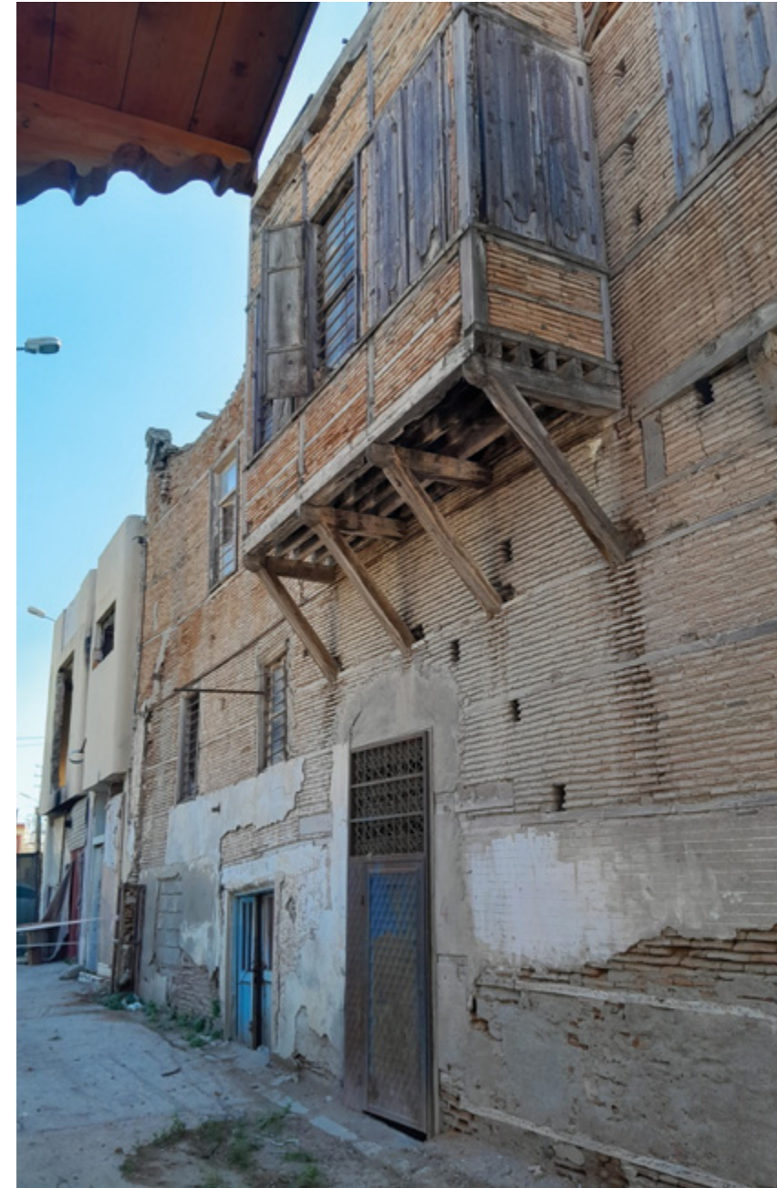
Şekil 3. Ahşap hatıllı tuğla yığma konut (SEY-7).
