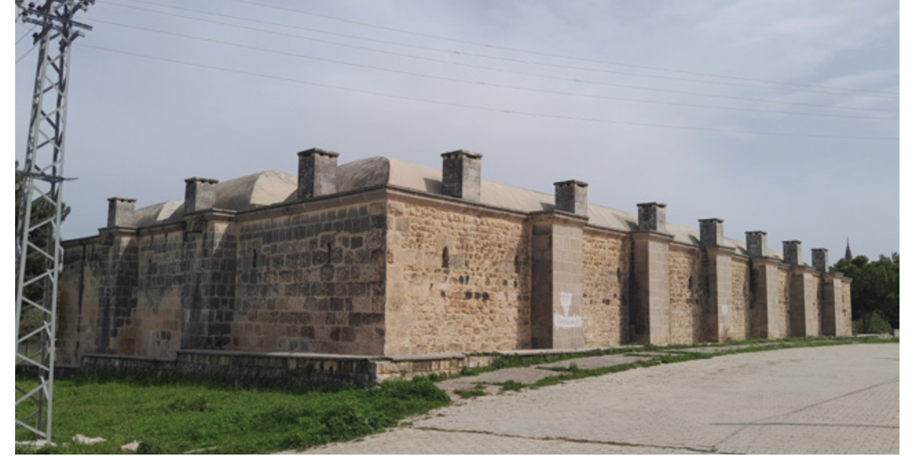
Şekil 7. Kurtkulağı Kervansarayı batı ve kuzey cepheleri.
