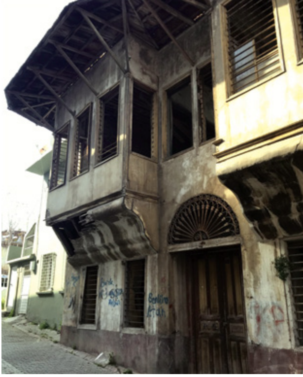
Şekil 5. Bağdadi tekniğiyle inşa edilmiş cumba ve destek elemanları (SEY-9).
