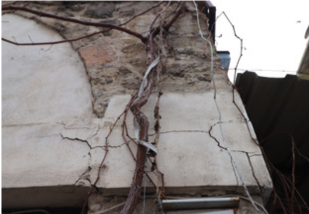
Şekil 9. Dükkan (KO-18) yapısında görülen hasar.
