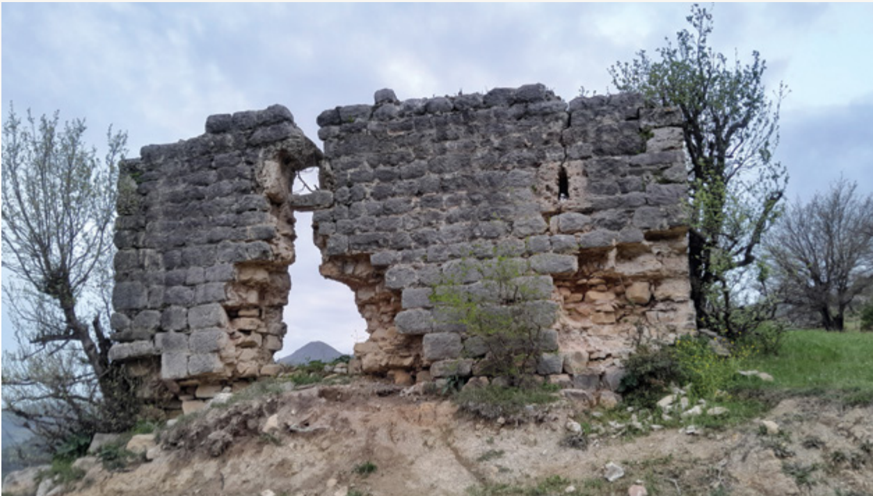
Şekil 1. Kozan, Karabucak Kilisesi doğu cephesi, 2023.
