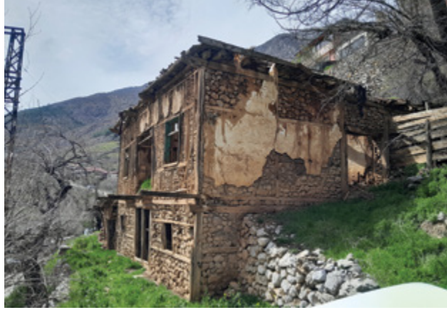
Şekil 2. Saimbeyli ilçesinde Saimbey Deresi'nin (Obruk) batısında bulunan sivil mimarlık örneği, Nisan 2023 (SA-12).
