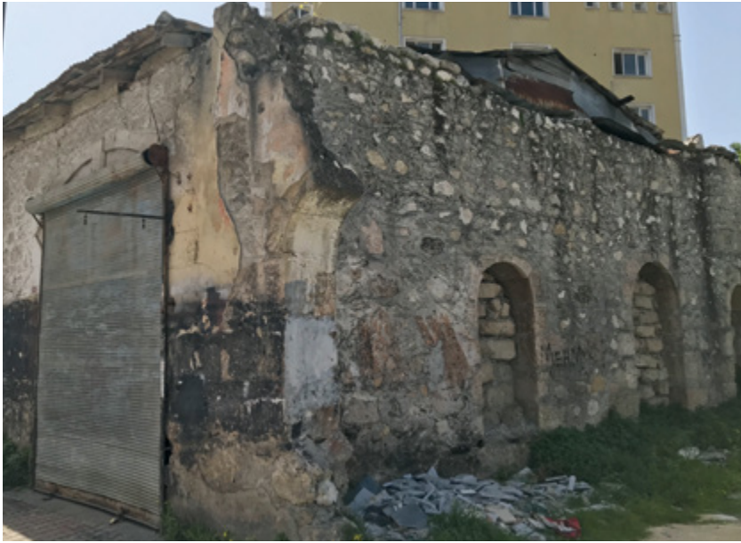
Şekil 12. CEY-26 yapısında görülen yapısal bozulmalar.
